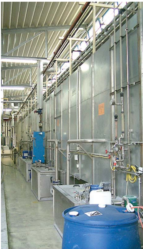
In der 6-Zonen-Durchlaufspritzanlage werden täglich etwa 8000 bis 10 000 Profile vorbehandelt
